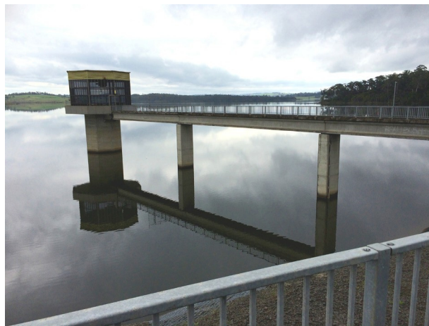
図1. ブレーロックダムの取水口（オーストラリア）
