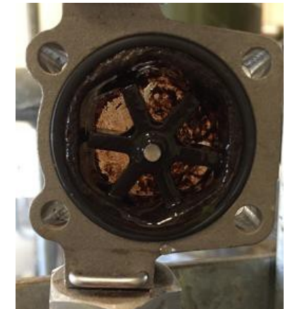
設置された装置と炭化水素汚染に影響を受けたRO膜
